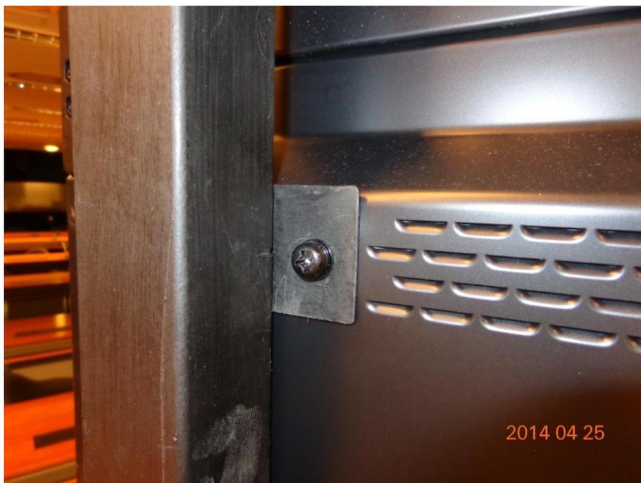
**Figura 7 – Detalhe de fixação da barra de metal no monitor.**
