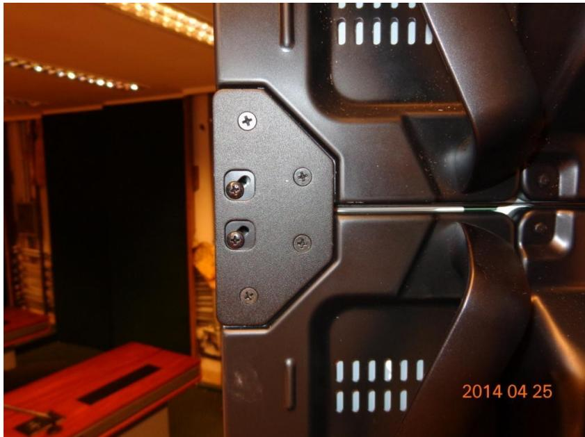
**Figura 5 - Dispositivos metálicos de travamento lateral**
